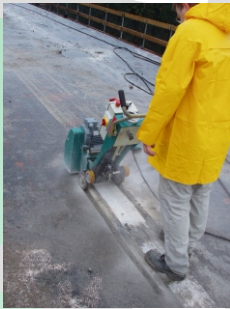
Staubfreies Kugelstrahlen bis Arbeitsbreite von 715 mm: die Betonoberfläche wird fachgerecht für die Beschichtung (Abdichtung nach ZTV- Haftzugwert 1,5 N/mm 2 ) vorbereitet - letzte Rückstände entfernt und gleichzeitig porentief gereinigt
